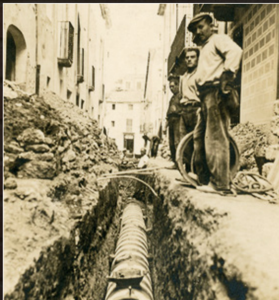
Construcció col·lector al carrer de Sant Antoni, 1932.
