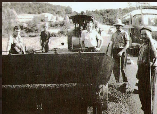
Treballs d'asfaltatge de la primera carretera de Girona.
