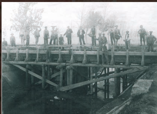
Construcció d'un pont per la carretera travessant el Terri.
